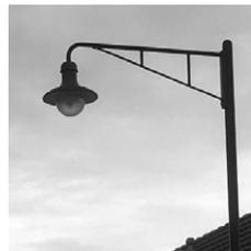
Im Rahmen der Abklärungen wurde am Hübeliweg, in Absprache mit dem Gemeinderat, von einer Privatperson versuchsweise ein Retrofit-LED-Leuchtmittel bei einer Leuchte eingesetzt. Diese Birne ist ein Leuchtmittel mit LED-Technologie, das in die bestehende Fassung und Vorrichtung passt.
